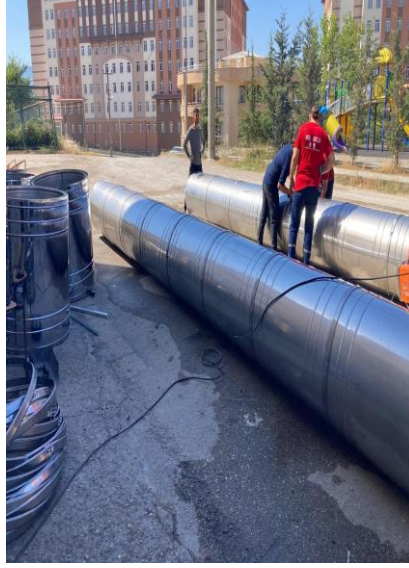
Isıtma Sistemi Montajı
